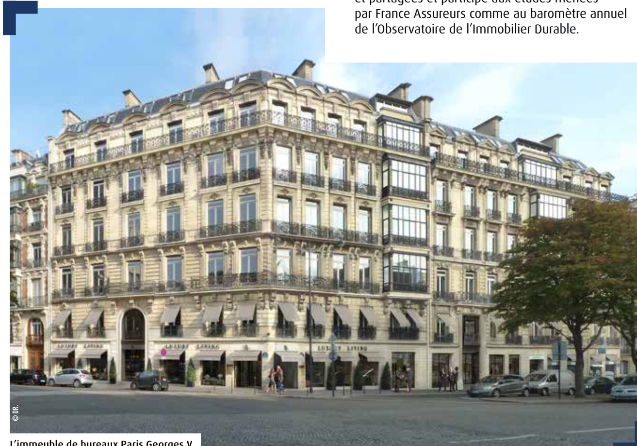
L'immeuble de bureaux Paris Georges V
